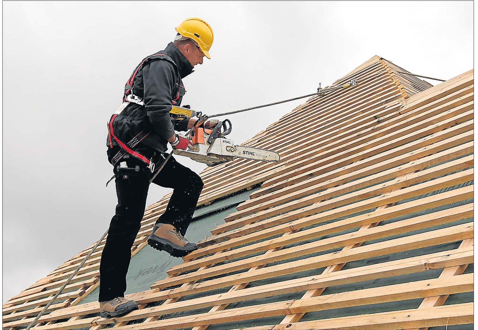
Absturzgefahr bedeutet Lebensgefahr: Aus diesem Grund muss bei der Arbeit in der Höhe Sicherheit großgeschrieben werden.
